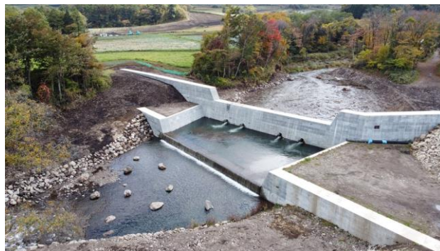
図-9 湯尻川下流砂防堰堤完成写真
