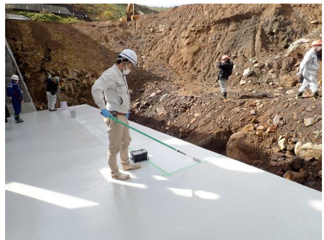
図-7 塗着補強技術施工状況
