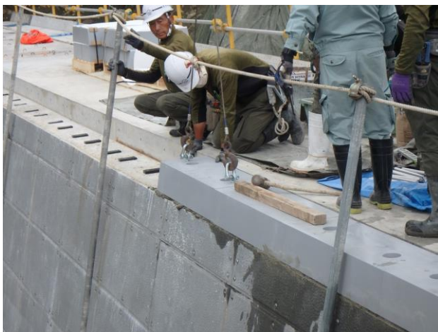
図-5 ESCON保護パネル施工状況
