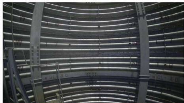
図-8 UAVで撮影した集水井内の状況
