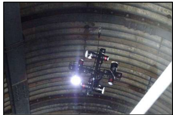
図-4 点検の状況
