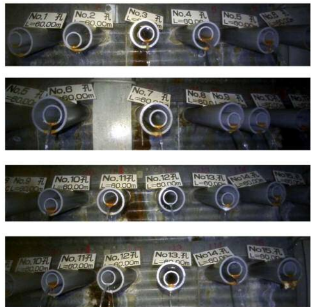
図-7 集水ボーリング孔の状況
