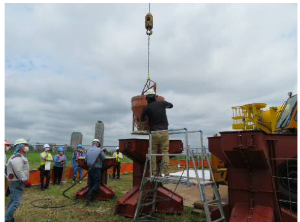
図-4 CO 2 吸収根固めブロックの打設状況
