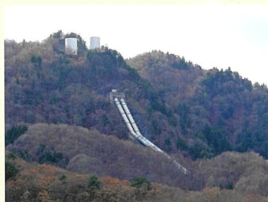
玉原発電所(サージタンクと水圧鉄管)→
