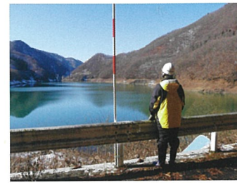
貯水池の点検
