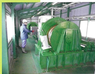
ゲートの点検
