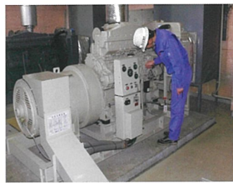
電気通信設備の点検
