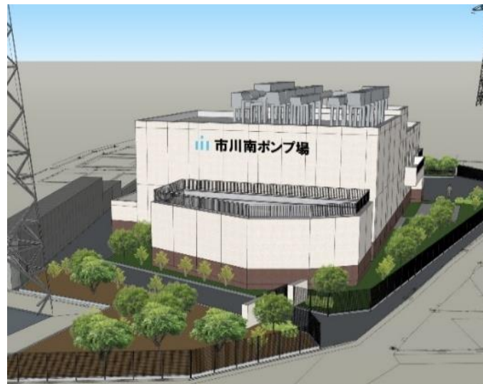
市川南ポンプ場イメージ(建設中)
