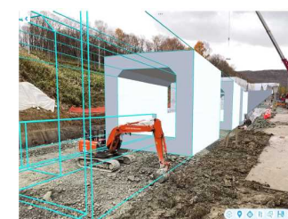
掘削作業時にARと比較
