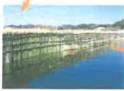
設置された保護柵
