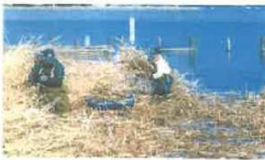
浮遊・堆積物の除去作業
