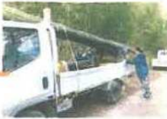
保護柵に使う竹の切り出し作業
