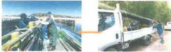
保護柵の設置作業
