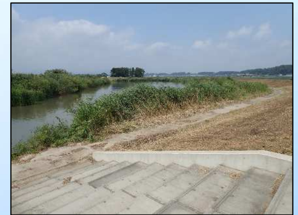
掘削前：R1年9月11日撮影
