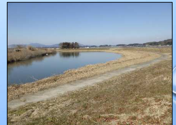
掘削後2年目：R4年1月28日撮影
