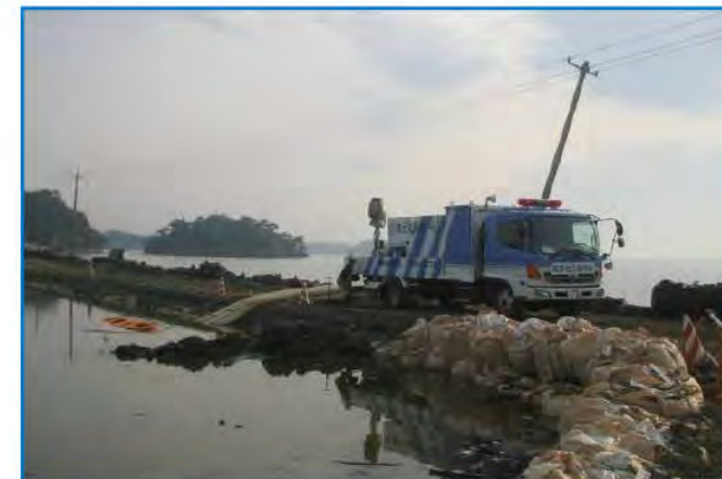
東名地区での排水作業(宮城県東松島市)
