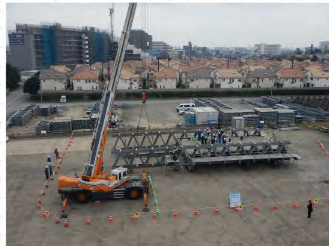
応急組立橋架設訓練状況
