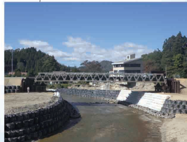
■ 応急組立橋 災害時に橋の流失や道路決壊によって交通が遮断されたとき、早急に交通路を確保するために使用します。
