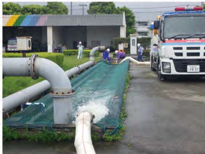
災害対策用機械操作訓練状況
