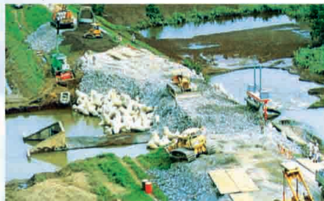
■ 根固めブロック 河川等の堤防が決壊した時に応急復旧のために使用します。
