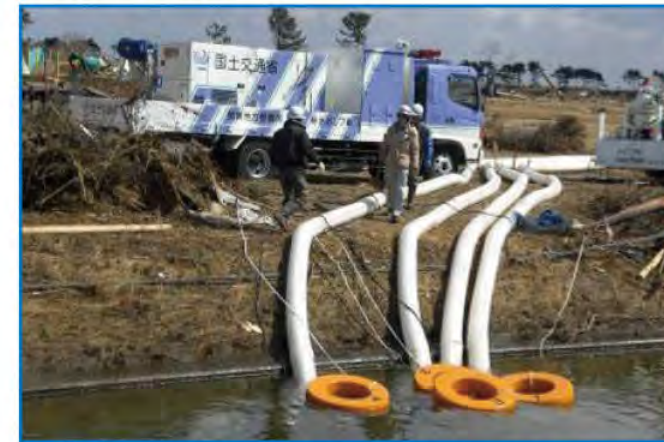
仙台空港周辺での排水作業(宮城県名取市)
