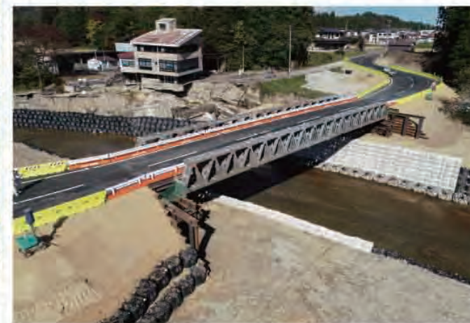
応急組立橋架設後
