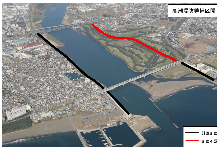
図 3-6 高潮堤防整備区間と整備状況
