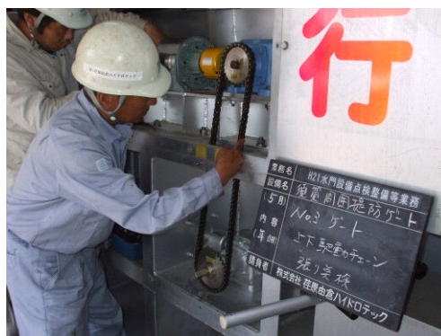
写真 6-3 機械設備点検の状況
