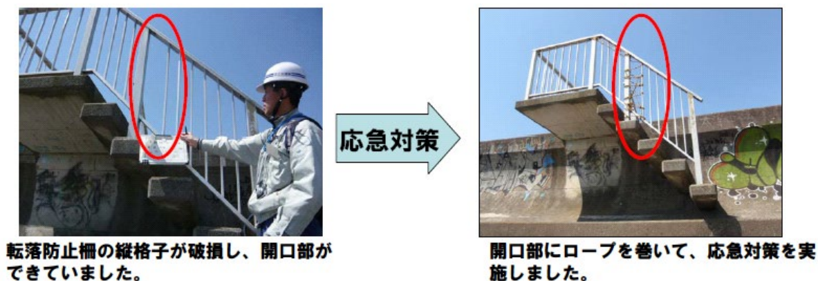
写真 5-4 親水施設の点検の状況（相模川右岸・平塚市）
