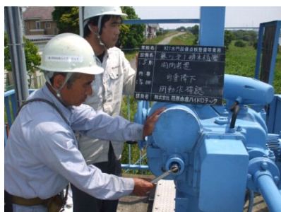
ゲートの開閉点検
