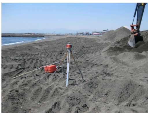
写真 6-2 掘削工事の状況（河口砂州 掘削工事状況）
