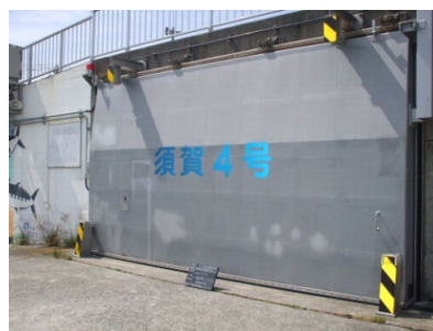
陸閘の開閉点検
