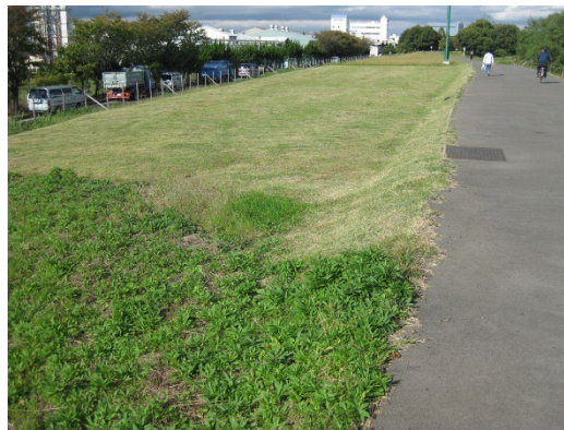
写真 6-6 側帯（四宮地区）
