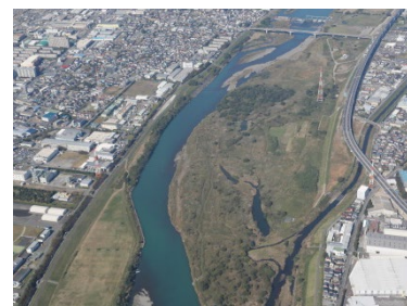
写真 5-1 樹木繁茂状況
