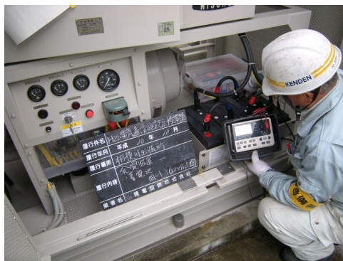
写真 6-4 電気通信設備点検の状況
