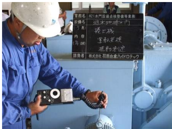
写真 6-1 機械設備点検の状況
