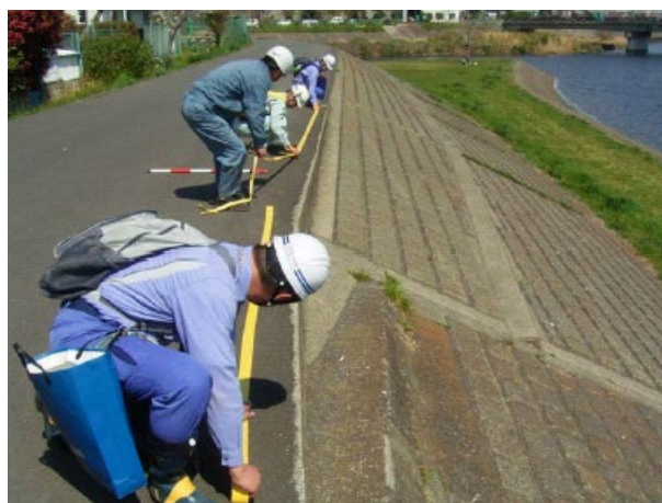
写真 5-4 親水施設の点検の状況
