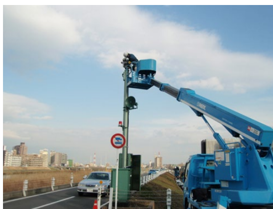
写真 6-5 CCTV 点検の様子（鶴見川右岸 9.7k 付近）
