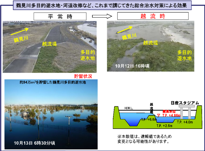
図 3-8 鶴見川多目的遊水地と令和元年 10 月洪水の状況 ＜出典：「令和元年台風 19 号出水概要」（令和元年 12 月、京浜河川事務所）＞
