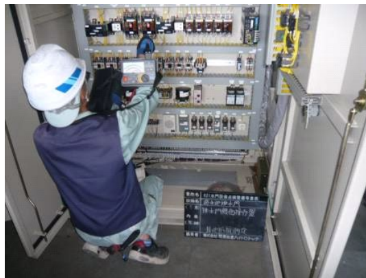
写真 6-2 電気通信設備点検の状況
