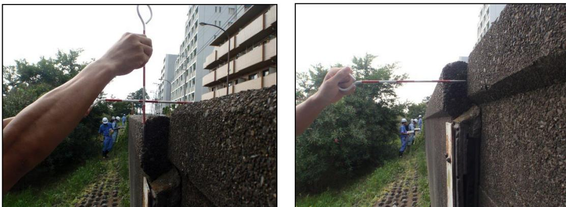
写真 6-9 目地部のずれ
