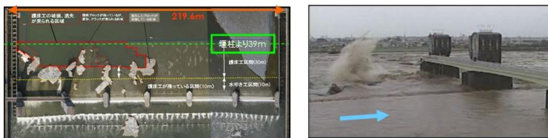
図 3-5 平成19年9月出水時の二ヶ領宿河原堰の被災状況
