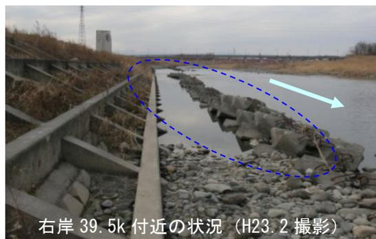
写真 6-10 根固め工
