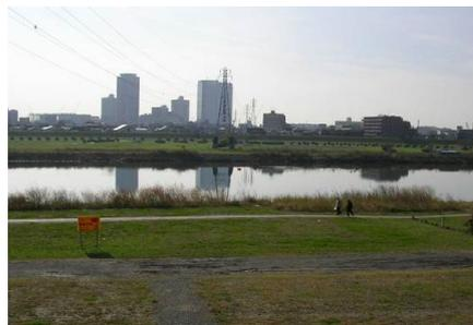
写真1-4 複断面河道となる多摩川下流部（13km付近）
