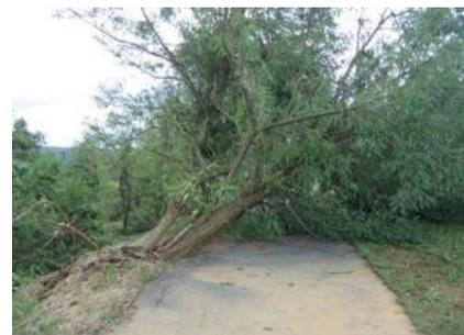
写真 6-1 台風で倒れた樹木による堤防の損壊状況
