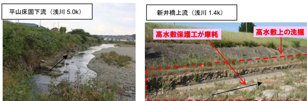
図 6-1 浅川河岸部の被災状況（平成 20 年 8 月出水）
