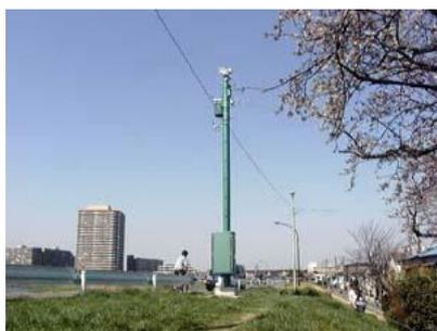
写真 6-3 CCTV カメラの設置状況
