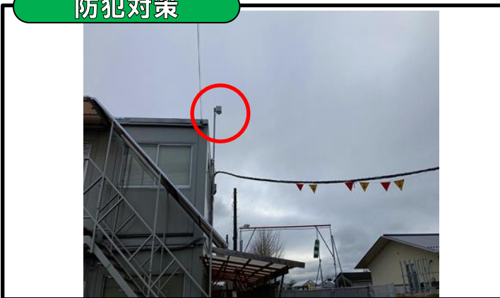
工事エリア監視カメラ設置
