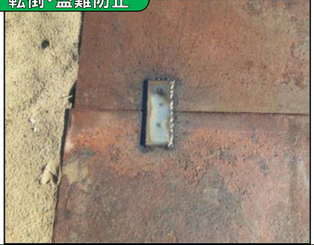
敷鉄板のずれ止め措置の実施
