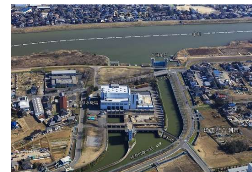
八潮排水機場
