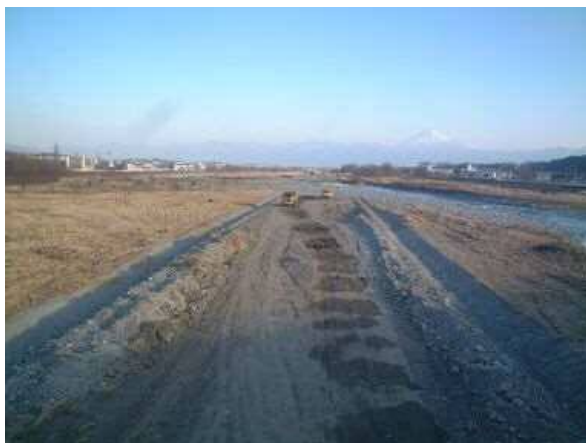
写真 6-1 河道整正の状況
