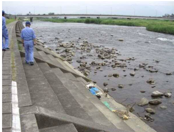
写真 5-6 親水施設の点検実施状況
