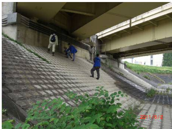
写真 6-18 橋梁橋台周辺の点検状況
