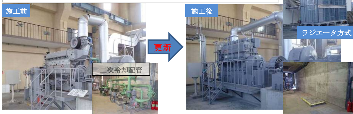
写真 3-8 老朽化が進んでいる排水機場
