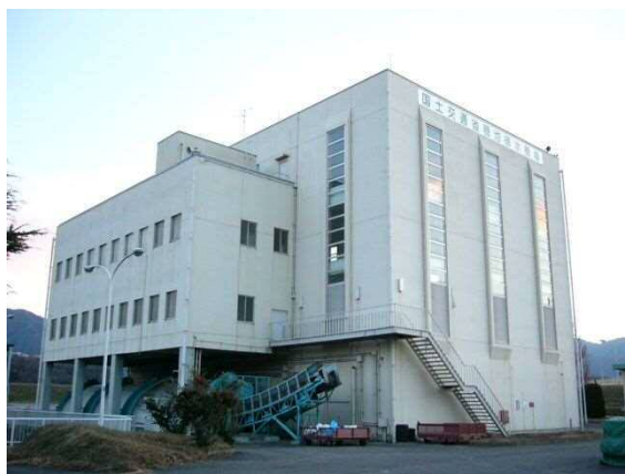
写真 3-7 排水機場全景（穏池排水機場）
