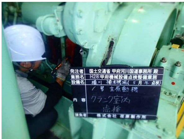
写真 5-10 排水機場点検（エンジン点検）
