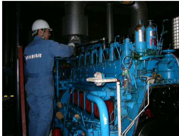
写真 6-4 排水機場（エンジン整備）
