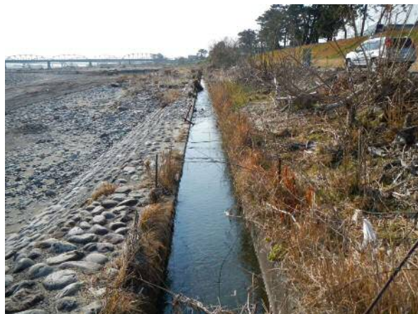
写真 6-23 水路下流の状況
