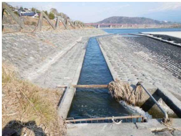
写真 6-22 水路上流の状況
