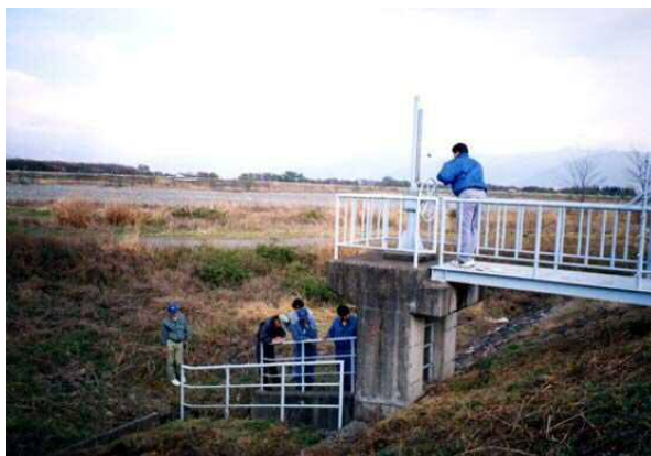
写真 3-11 許可工作物点検状況
