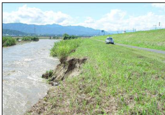
笛吹市石和町小石和地先（笛吹川右岸）
