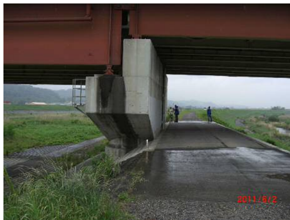
写真 6-19 橋梁橋脚周辺の点検状況
