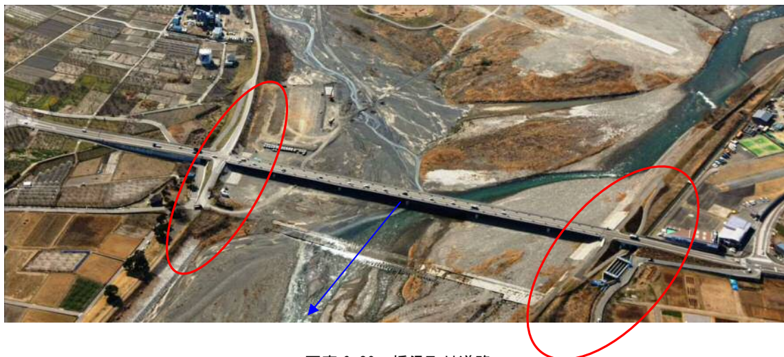
写真 6-20 橋梁取付道路
