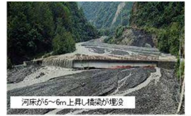
早川町稲又谷地区の河道内土砂堆積(昭和57年8月洪水)
