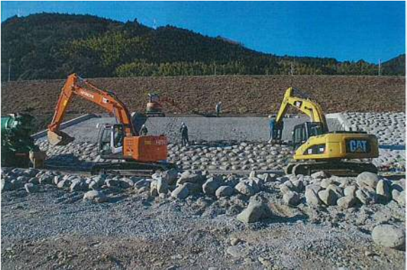
写真 3-2 特採護岸施工状況
