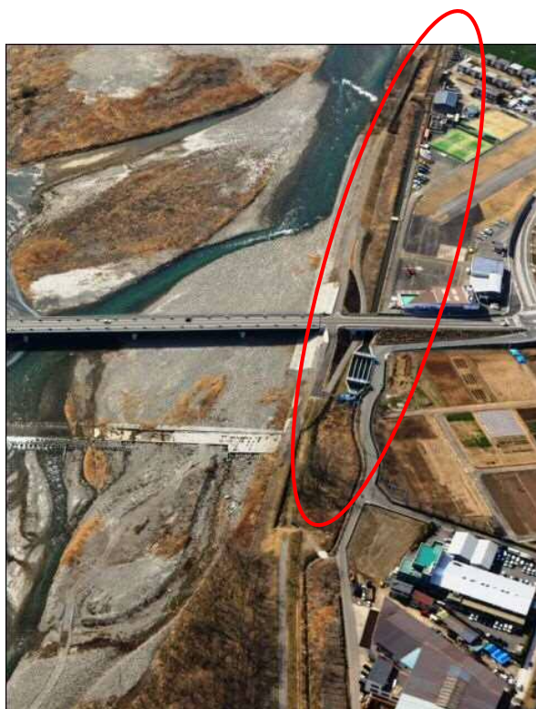
写真 6-24 堤内水路の状況
