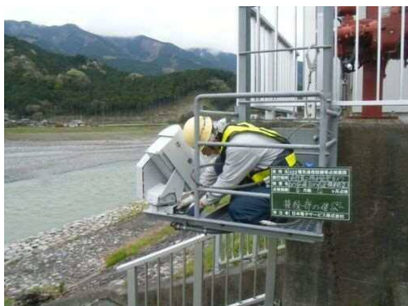
写真 6-11 CCTV カメラ（河川管理用カメラ）・機側装置点検
