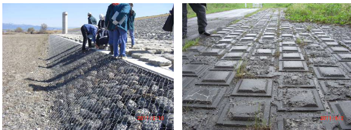
写真 6-2 護岸の点検状況
