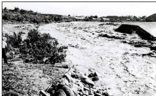
根津橋上流左岸破堤
