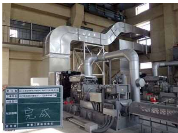
写真 6-13 排水機場（排水ポンプ整備）
