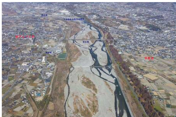
写真 1-1 富士川（釜無川）信玄堤・高岩付近
