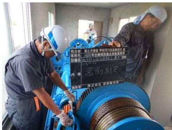
写真 5-8 樋門・樋管点検（ゲート開閉装置点検）
