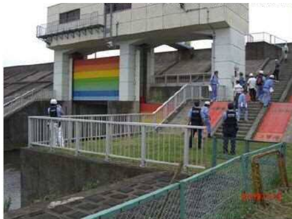
写真 6-16 河川管理施設の操作訓練状況
