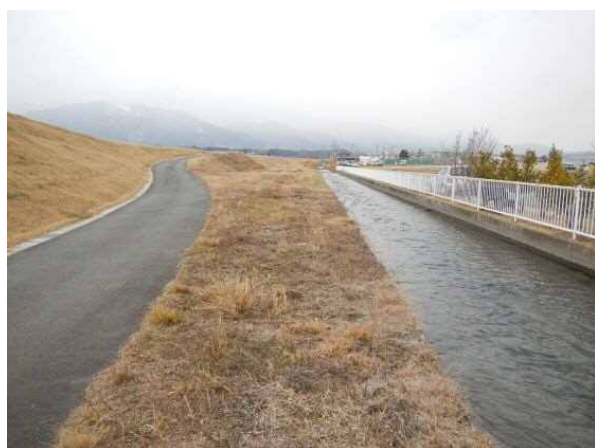
写真 6-25 堤内水路上流の状況
