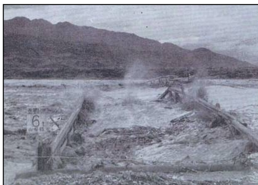
三郡東橋の流出
