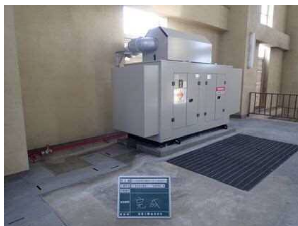
写真 6-14 排水機場（エンジン整備）
