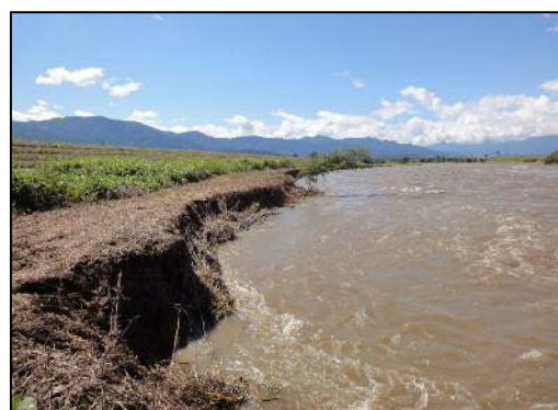
笛吹市石和町小石和地先（笛吹川左岸）
