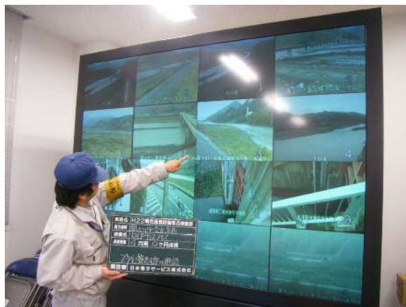
写真 6-6 映像表示装置点検
