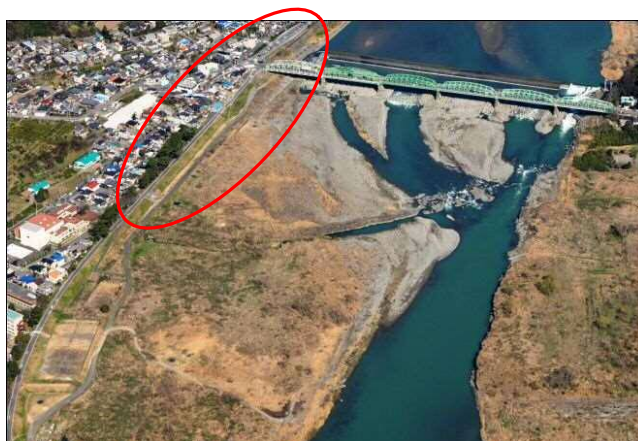
写真 6-21 堤外水路の事例
