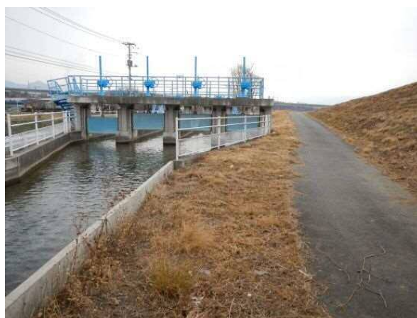
写真 6-26 堤内水路下流の状況
