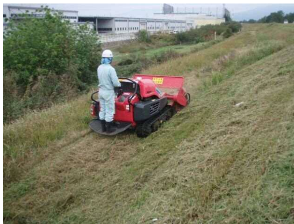
写真 5-1 堤防除草状況
