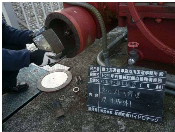
写真 6-10 ゲート開閉装置整備
