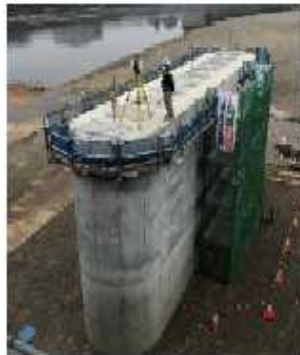
従来施工 (高所での測量)
