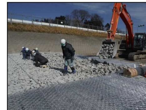
コンクリート殻の利用状況
