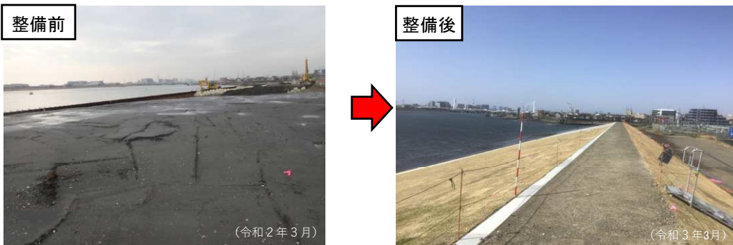
高潮対策 多摩川左岸1.4k周辺(令和3年3月完成)
