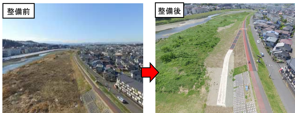
支川浅川における緩傾斜坂路の整備例（左：整備前、右：整備後）
