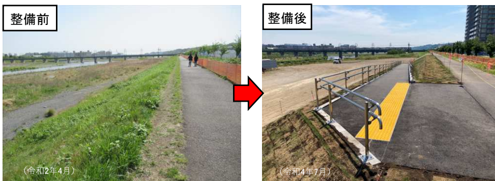
多摩川における緩傾斜坂路の整備例（左：整備前、右：整備後）
