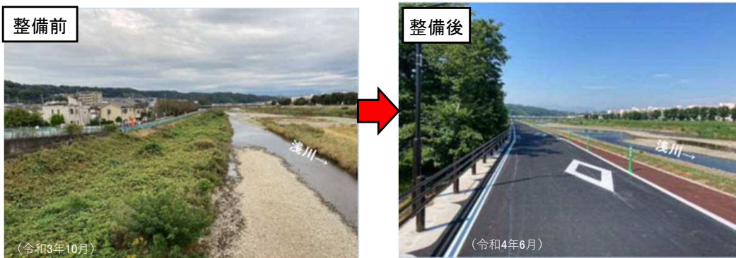
築堤 浅川左岸5.6k周辺(令和4年6月完成)
