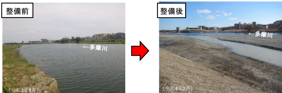
河道掘削 多摩川宿河原堰上流(令和4年2月完了)
