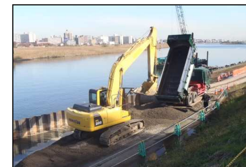
盛土材の搬入状況
