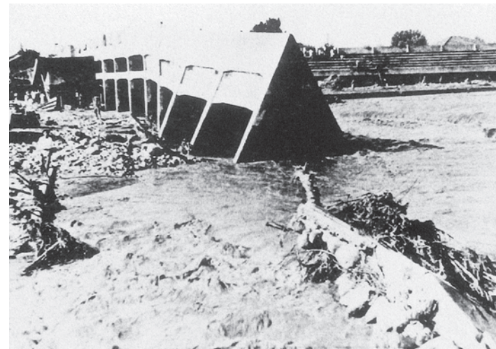
倒壊した新川グランドのスタンド(桐生市稲荷町)
