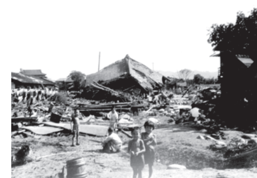
流失・倒壊で家を失った子供(桐生市内)
