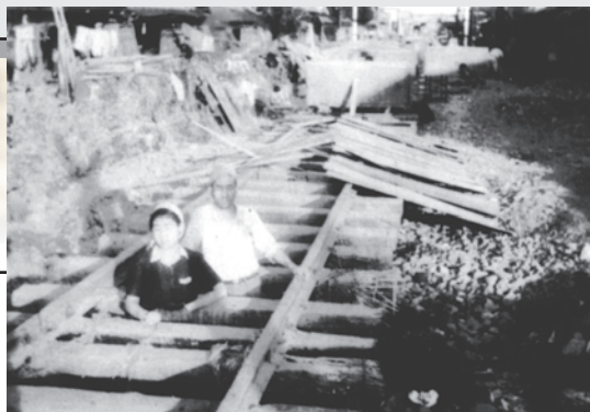
枕木の下に盛土が流れてレールが 浮いてしまった両毛線(足利市通1丁目)
