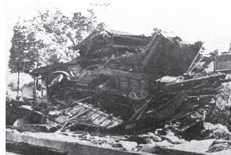
二階より高く押し上げられたトラック(桐生市境野町)
