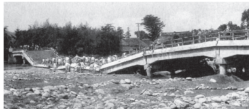
桐生川にかかる旧50号線境野橋の被害(桐生市境野町)
