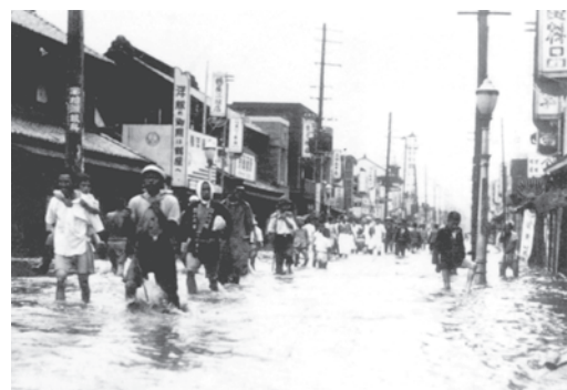
浸水した街中を歩く人々(足利市通2丁目)
