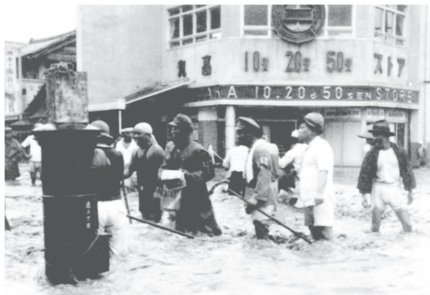
商店街にはん濫した洪水のなかを歩く人々(足利市通2丁目)
