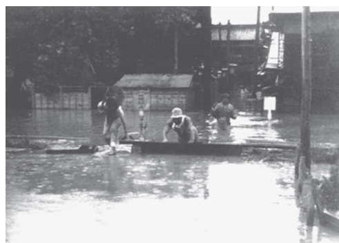
浸水状況(足利市通6丁目付近)
