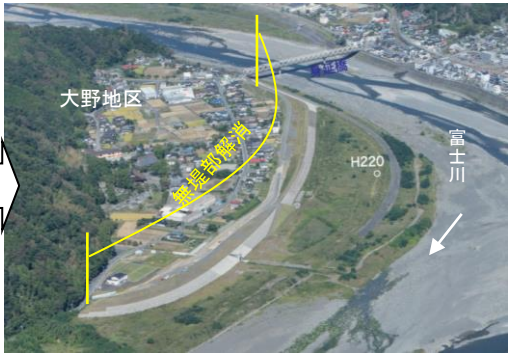
整備後(H26年度撮影)
