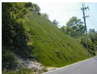
切土(法面保護)
