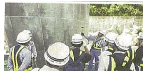
旭高架橋打音点検の様子
