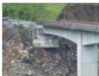
斜面変状による橋台の沈下
