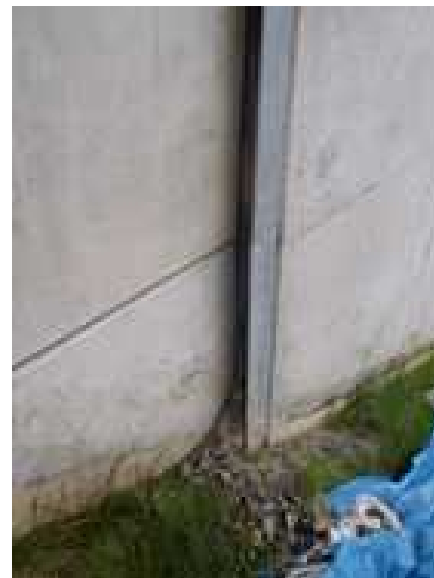
写真 土砂のこぼれ出し例
