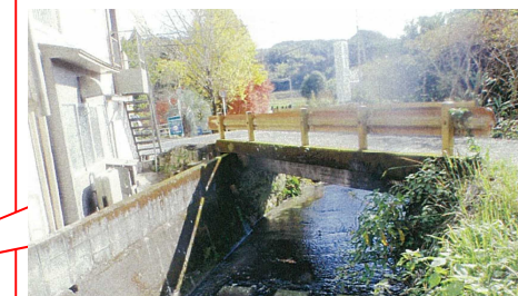
老朽橋の撤去
