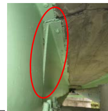
主桁の変形
