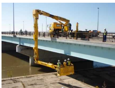
橋梁点検車による点検
