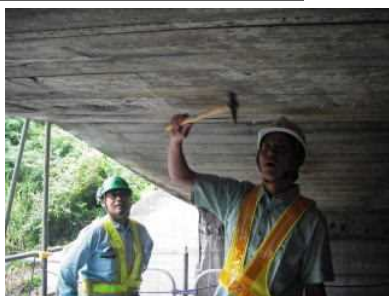
目視及びハンマーによる打音検査
