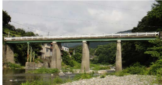
&lt;御鉾橋の状況&gt;
