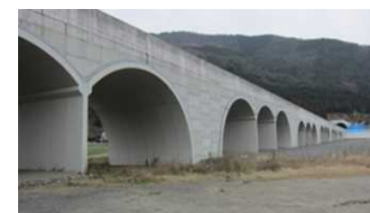
アーチカルバート
