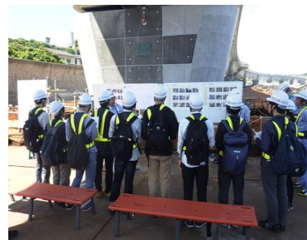
補修工事説明状況
