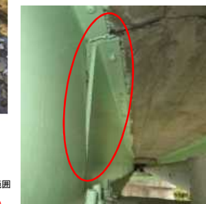
主桁の変形
