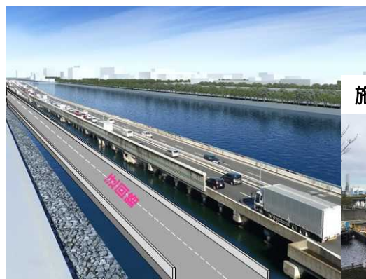
<更新の事例: 首都高速 東品川栈橋・鮫洲埋立部>
