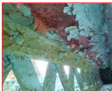
鋼材の腐食
