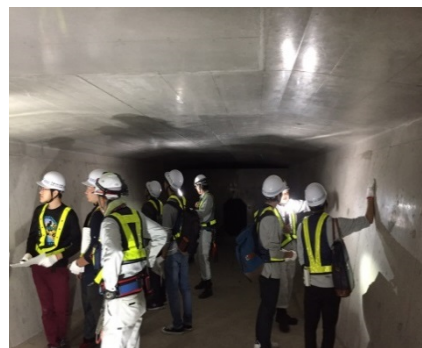
箱桁内点検実習状況
