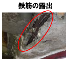
鉄筋の露出
