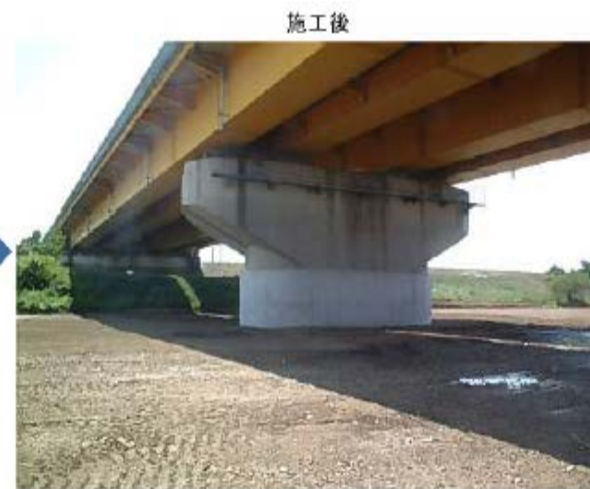
耐震補強見学箇所(常磐道 那珂川橋)
