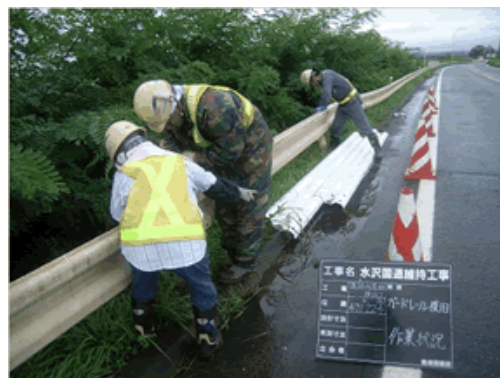
＜防護柵の取替＞
