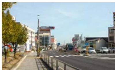
例:共同溝整備を行う・行った箇所
