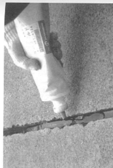
写真-4.2.11 シール材注入状況
