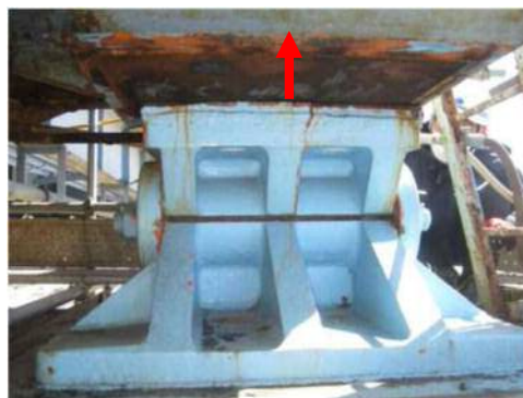
P2支承（固定）： 下弦材と上沓の間の溶接が外れ上部構造が移動
