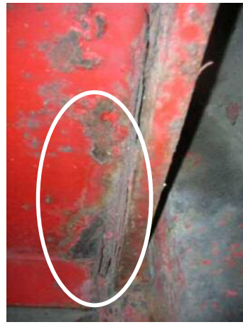
主桁の腐食
