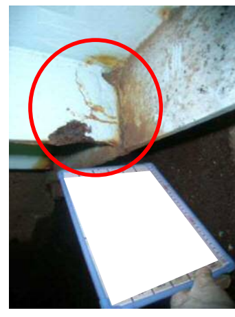
主桁の腐食
