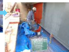
【防錆塗料1回目】
