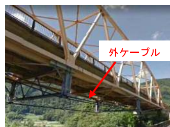
鋼橋の外ケーブル補強の例
