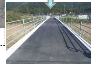
⑤As舗装⇒透れ目地設置(完了)
