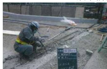
①箱抜きによる床版のはつり
