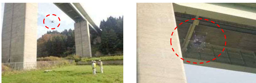
図Ⅱ－9 ドローンによる点検状況
