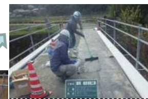
④常温型塗膜防水塗布⇒保護骨材(珪砂)散布
