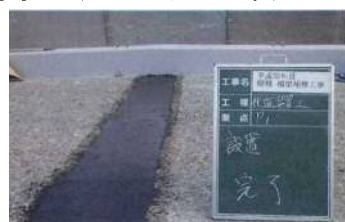
③高温伸縮性舗装設置
