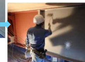
【防錆塗料2回目】
