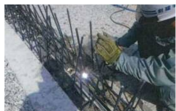
②金物溶接
