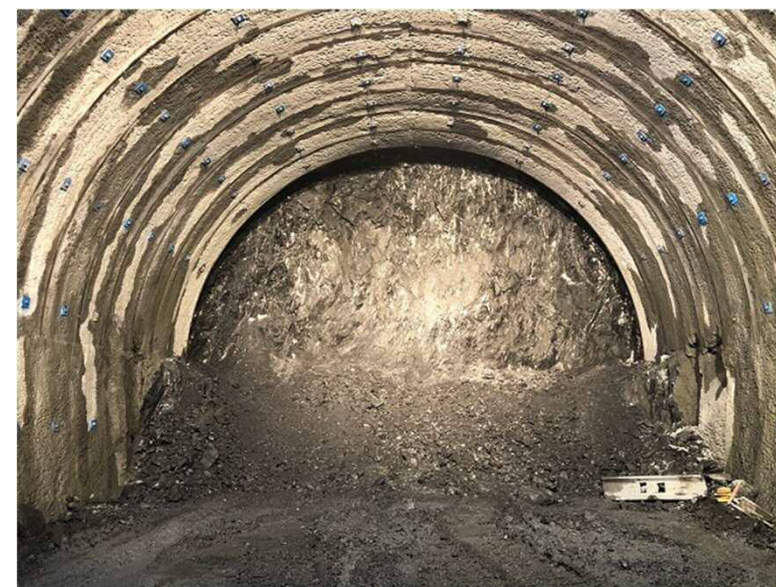
〔新小仏トンネル(仮称)掘削状況〕 写真:2022年7月 ※約130m/約2,300m掘削済 (2022年9月時点)
