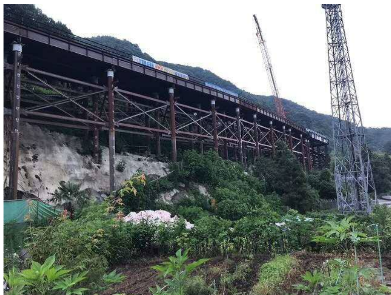
〔工事用道路(小仏トンネル東側坑口部)の整備状況〕 写真:2022年7月
