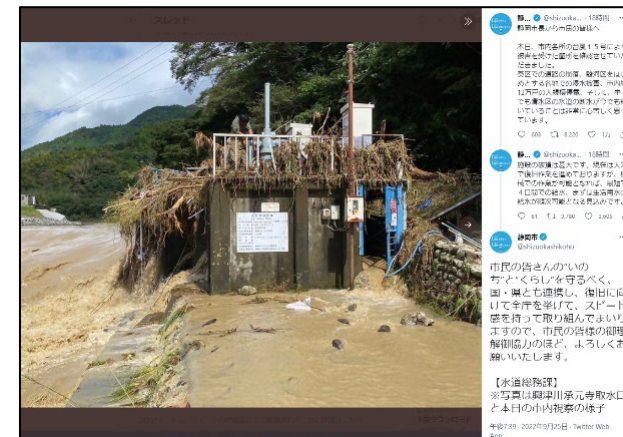
興津川取水口の様子(出典:静岡市Twitterより)
