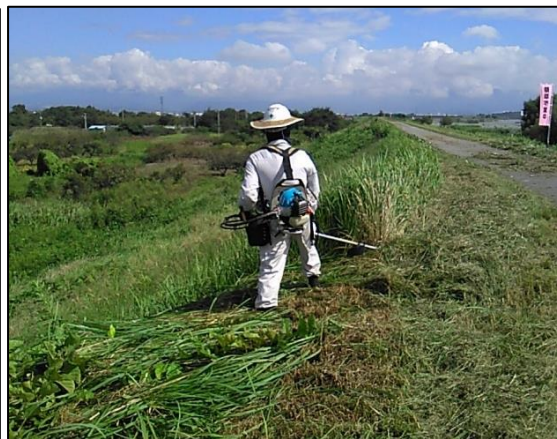
堤防除草の実施状況(肩掛け式)
