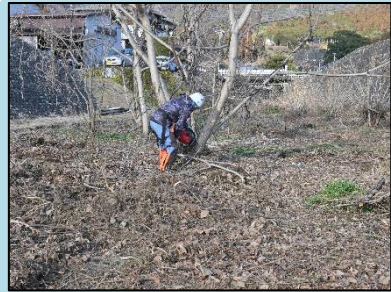
維持工事による樹木伐採状況
