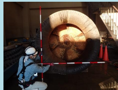
機械設備を伴う河川管理施設等の補修状況(排水機場ポンプの分解整備)
