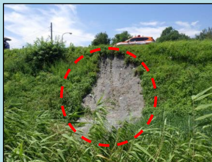
堤防・護岸の点検状況(法くずれ)
