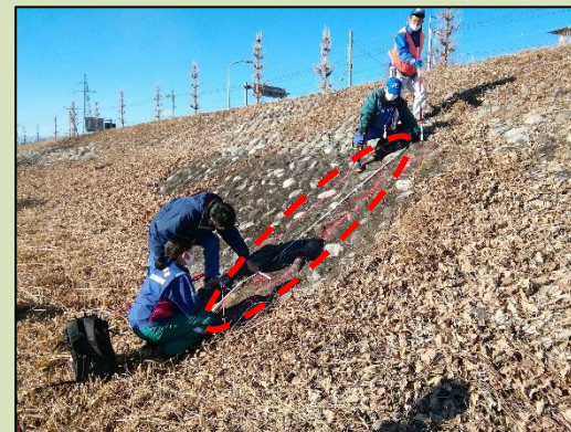
堤防点検状況
