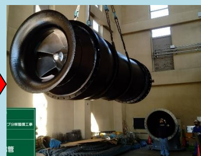
補修完了(排水機場ポンプの分解整備)
