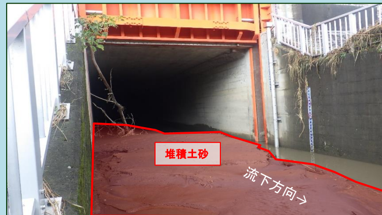
堆積土砂撤去前状況
