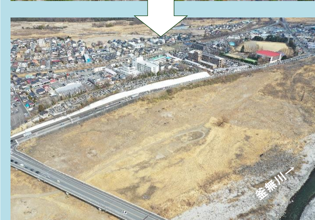
樹木伐採状況(上:伐採前 下:伐採後)
