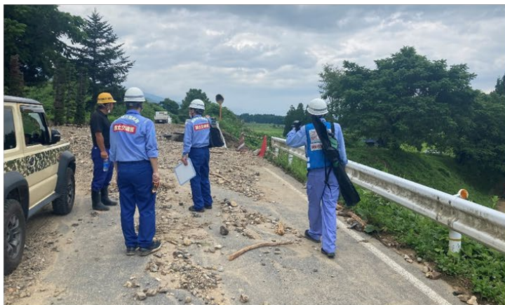
被災状況調査（寺泉地先）
