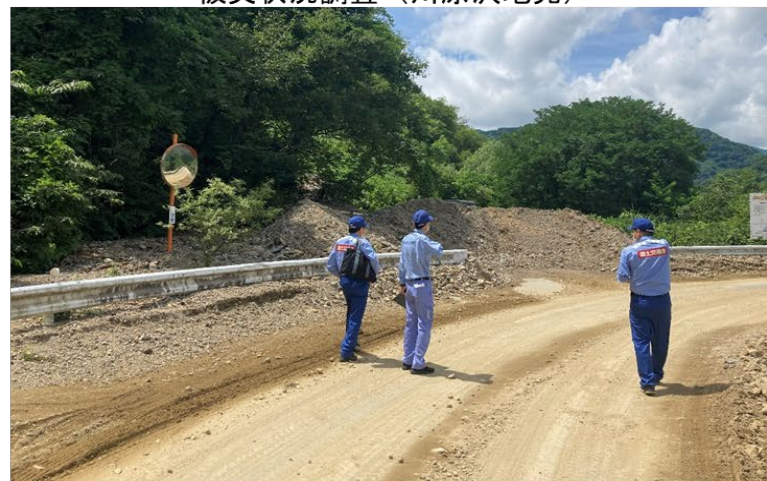
被災状況調査（寺泉地先）
