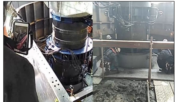
図9 施工状況映像（2方向から撮影）
