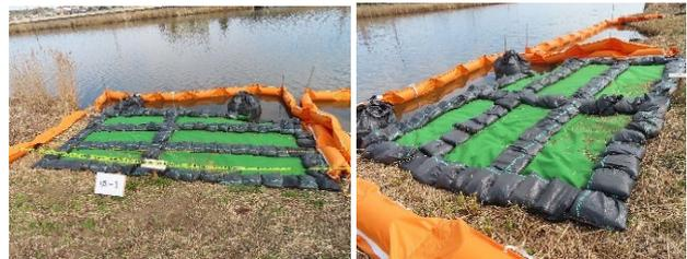
写真-6 試験施工ケース⑤(刈取+シート被覆)
