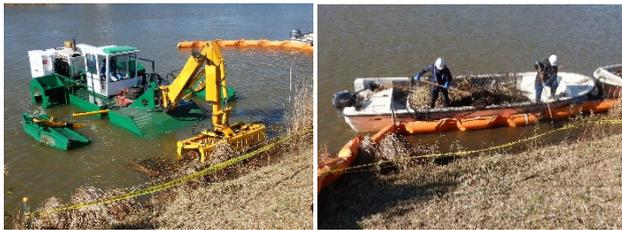
写真-2 ハイドロモグによる刈取の作業及び人力による回収作業
