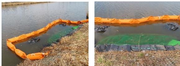
写真-7 施工ケース⑥（遮光 水中沈下）
