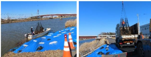
写真-3 ラフタークレーンによる搬出作業
