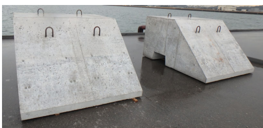
図-11 水和固化体ブロック完成状況
