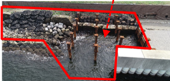
図-4 北側護岸全景(工事着手前)
