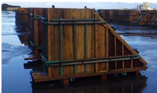
図-10 木製型枠組立状況
