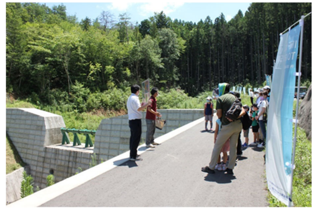
写真-3 大栗沢砂防堰堤での事業説明
