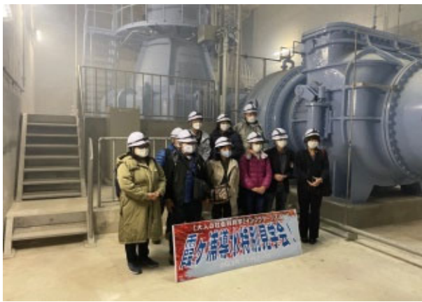
写真-6 霞ヶ浦導水施設の見学
