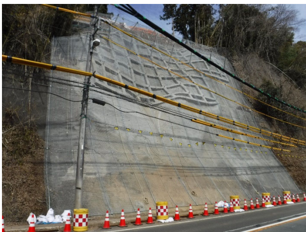
写真-4 法面復旧工事完了時の様子
