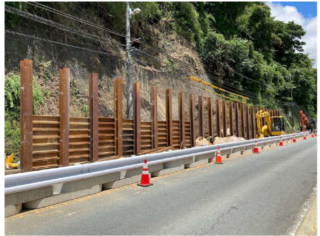
写真-2 仮設防護柵設置の様子
