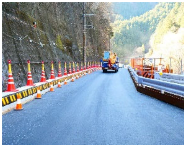
写真6 復旧完了後の道路状況
