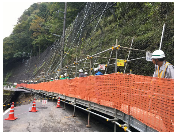
写真-2 仮設歩道設置状況
