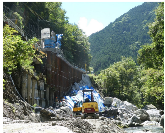
写真5 自走式回転掘削圧入工法の施工状況
