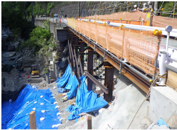
写真4 車両用仮設道路設置状況
