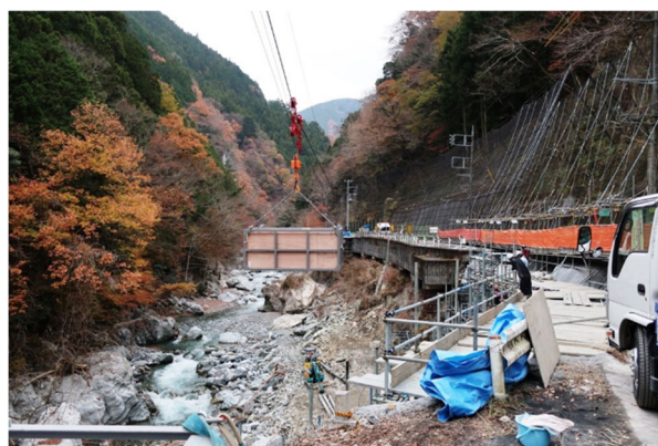
写真-3 索道設置状況
