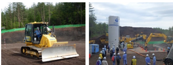
写真5 ICT施工現地学習会の様子
