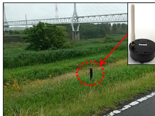
図-1 センサー設置状況（ポール内に内蔵）
