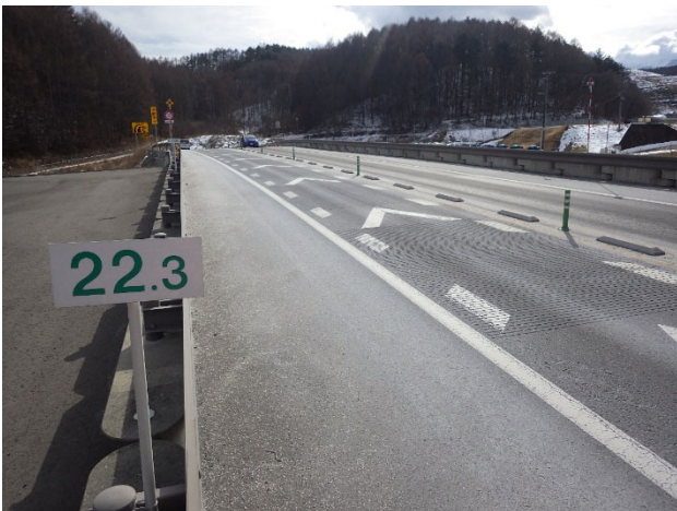
図-5 グルーピング工設置状況
