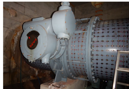
写真-4 除塩設備配管の板厚測定時の外観
