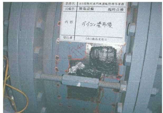
写真-5 パテ材による応急補修状況
