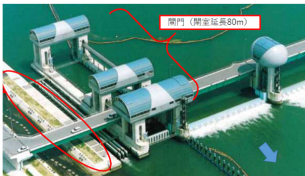
写真-2 長良川河口堰の閘門部の外観 1)
