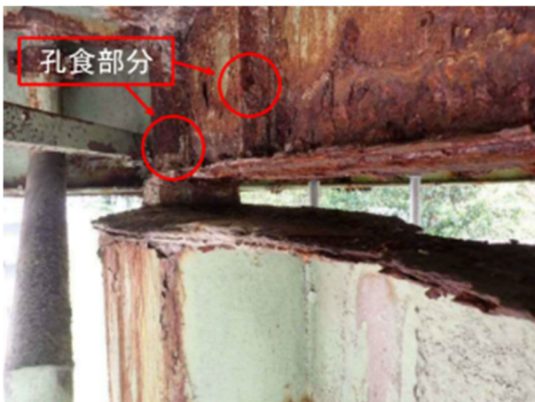
図-3 図-2と同じ歩道橋支点部の写真
