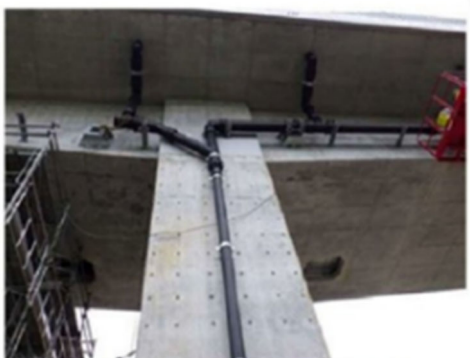
図-8 高密度ポリエチレン管への交換
