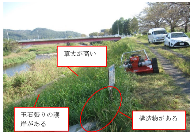
写真6 桐生管内での施工場所
