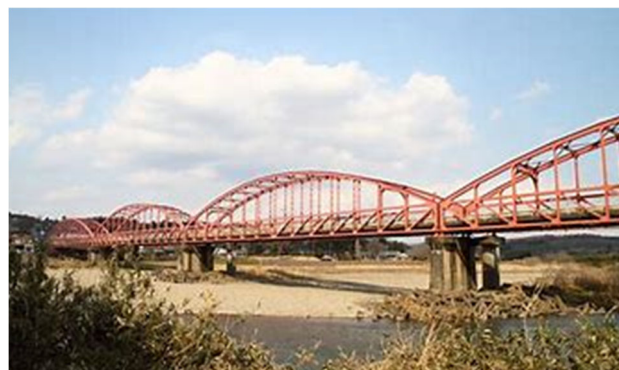
図-2 那珂川大橋
