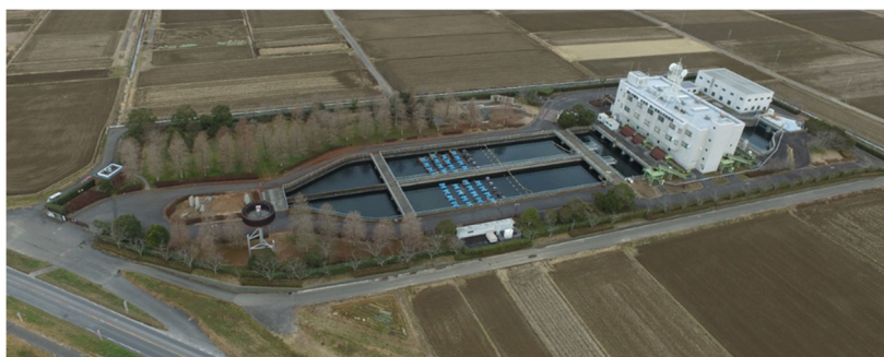
写真-1 利根機場全景
