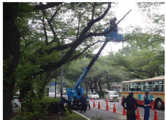
写真－4 高所作業車による枯枝点検
