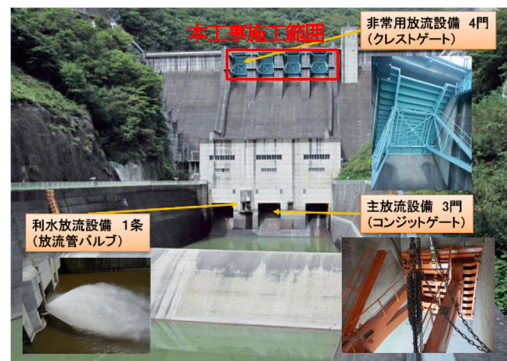
写真-1 菌原ダム 放流設備
