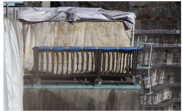
写真-6 クリーンルーム外観
