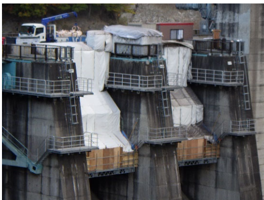
写真-5 板張り・防炎シート養生
