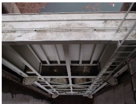
写真-8 相俣ダムクレストゲート(H19 塗装工事実施)
