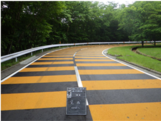
Fig6 薄層すべり止め舗装の施工例
