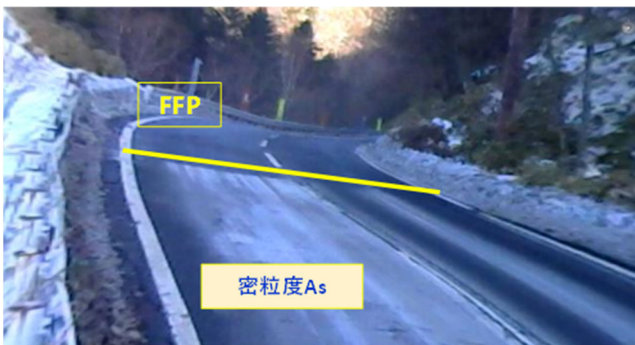
Fig.10 路面状況（第二いろは坂 明智第二TN出口・2020年8月施工）
