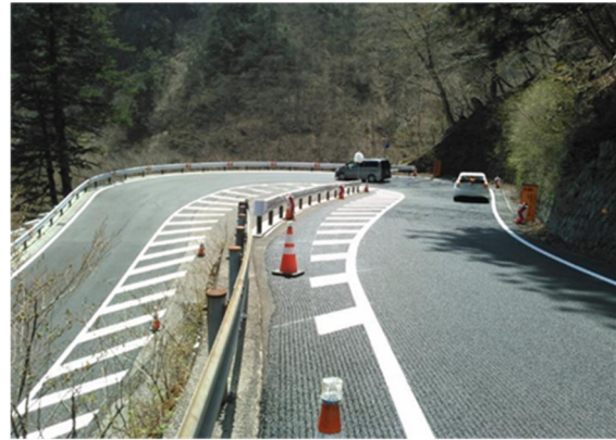
Fig8 FFP施工直後路面状況
