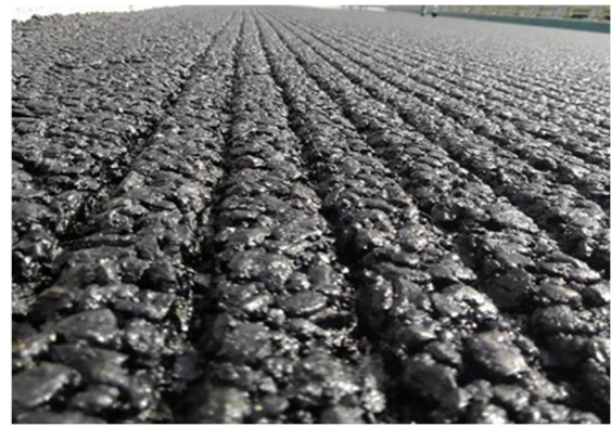
Fig.4 縦溝粗面仕上げ例
