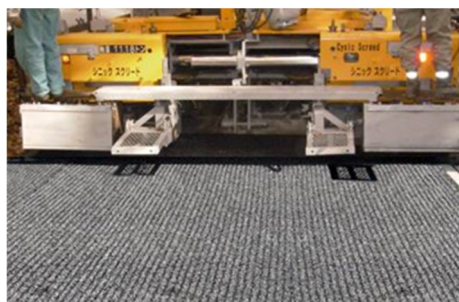
Fig.2 専用アスファルトフィニッシャーによる敷均し例
