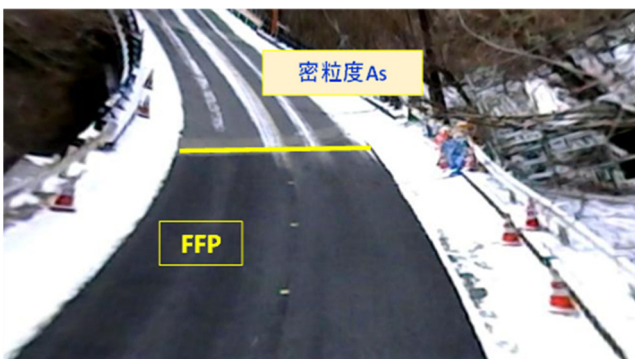
Fig.9 路面状況（国道122号・2021年2月施工）
