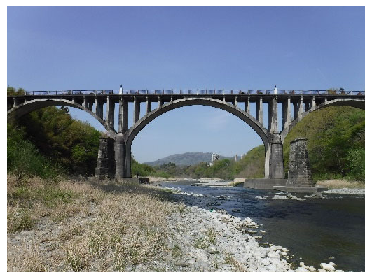
写真-1 秩父橋の全景
