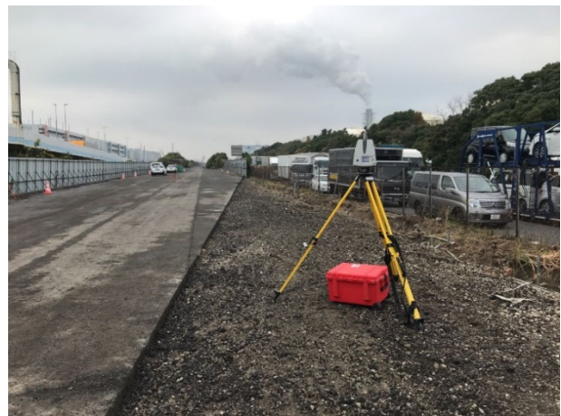
写真-1 3次元起工測量
