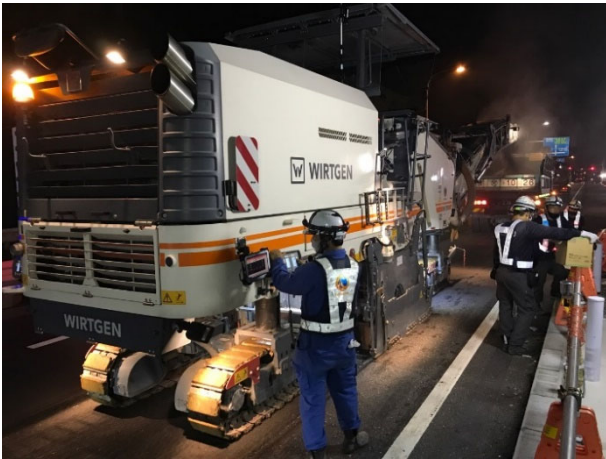
写真-2 路面切削
