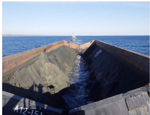
写真-1 土砂投入の様子
