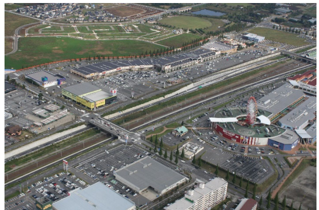
図-2 北千葉道路の供用状況(印西市)
