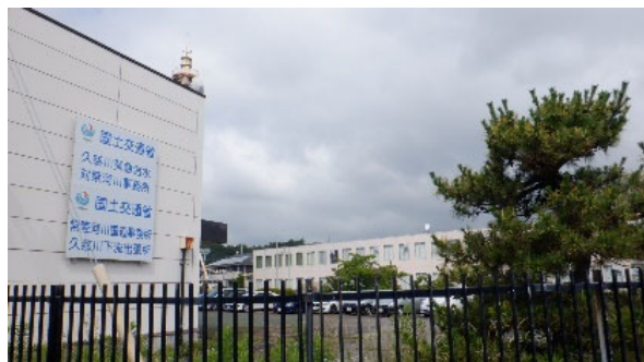
写真-1 久慈川緊急治水対策事務所
